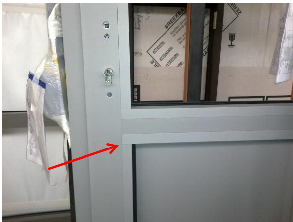
Foto: duidelijke kleurverschillen in 1 project
